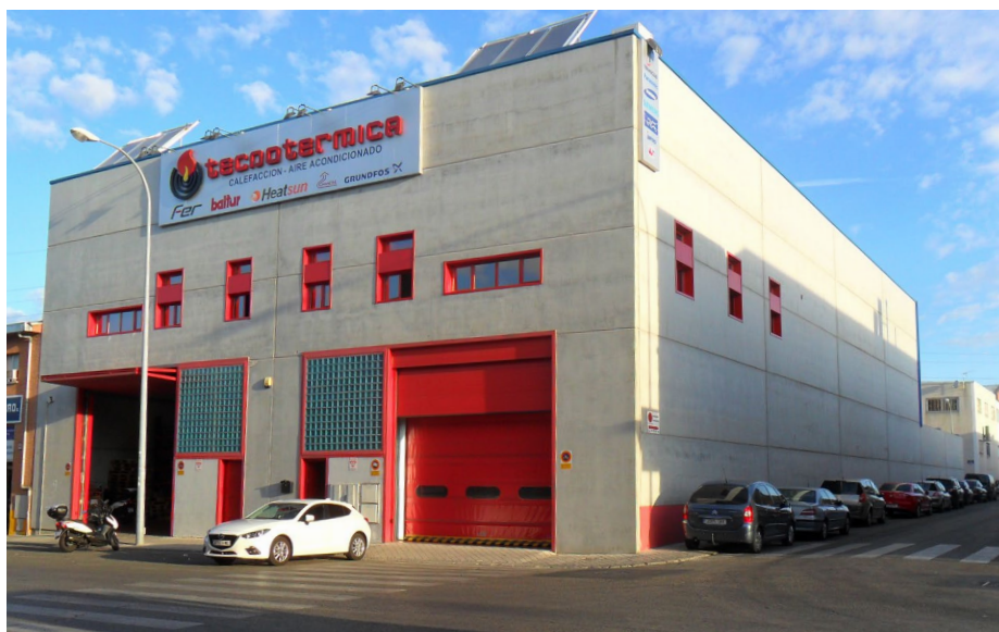
Fachada de la nave de Tecnotermica (Madrid)
